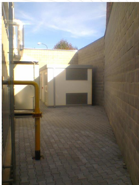
Tepelné hospodářství Prachatice s.r.o. – zdi kogenerační jednotky z BS-Akustik Z 200
