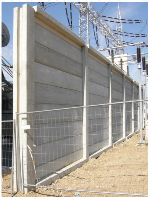
Rozvodna Čebín – BS-Akustik Z 100 ve stěnových panelech
