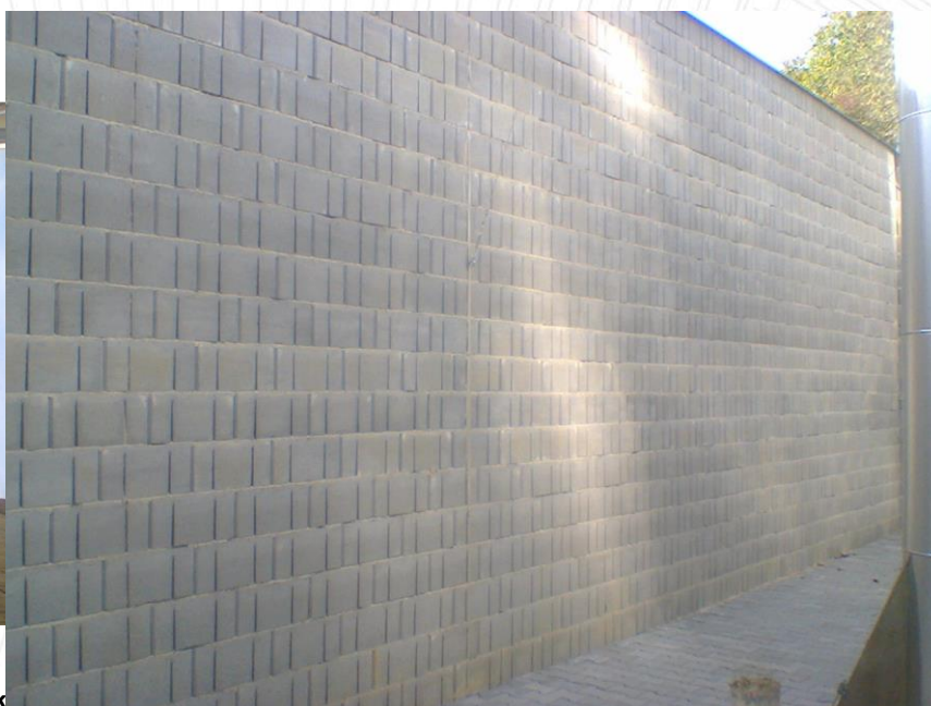
Tepelné hospodářství Prachatice s.r.o. – zdi kogenerační jednotky z BS-Akustik Z 200
