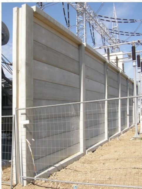
Rozvodna Čebín – BS-Akustik Z 100 ve stěnových panelech
