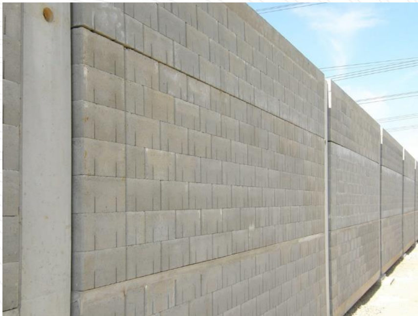
Rozvodna Čebín – BS-Akustik Z 100 ve stěnových panelech
